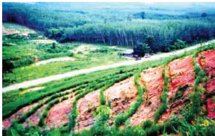
รูปที่ 2.12 การปลูกหญ้าแฝกในพื้นที่ลาดชัน
