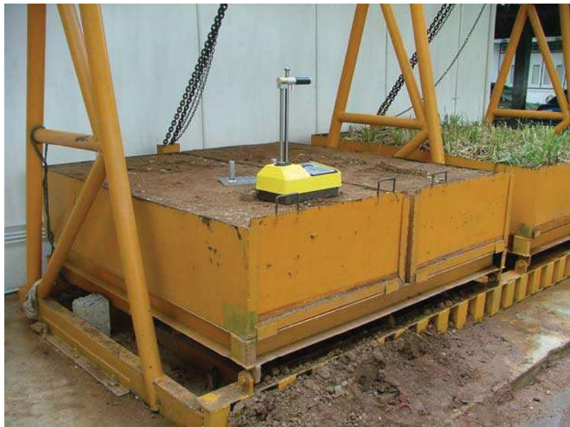
รูปที่ 3.12 การตรวจสอบความหนาแน่นโดยใช้เครื่องมือ Nuclear Density
